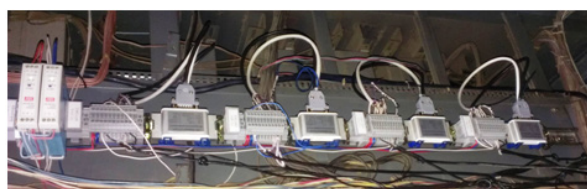
Рис. 11 – Установка функціональних перетворювачів
