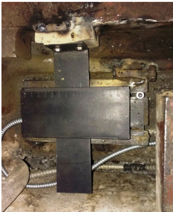
Рис. 10 – Установка первинного перетворювача для контролю розширення ЦВТ
