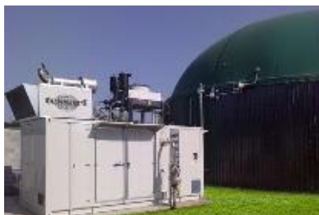
Рис. 1 – Когенераційна установка на біогазі [11]
